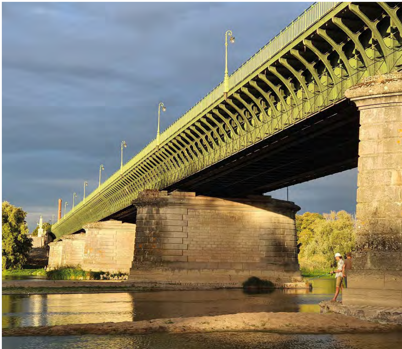
Pont-canal de Briare inscrit au registre des monuments historiques
